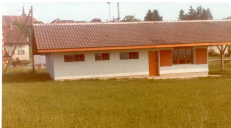
Vestiaires à leur fondation : 1977
